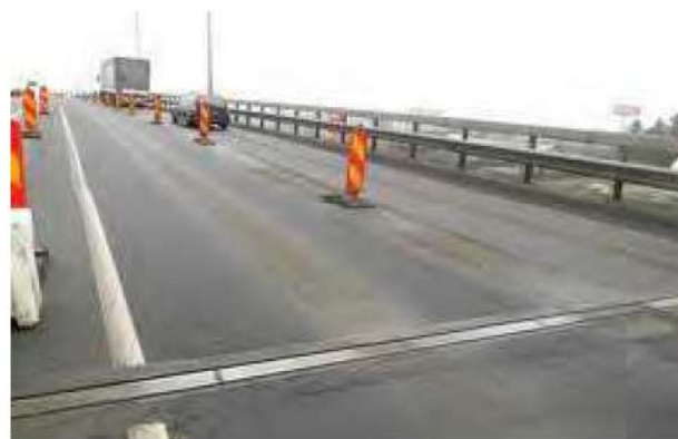
PROIECT : PASAJ CHITILA - MOGOSOAIA, BUCURESTI MONTAJ DISPOZITIVE GUMBA TIP BJ50, Bj75, Bj100, BJ230
