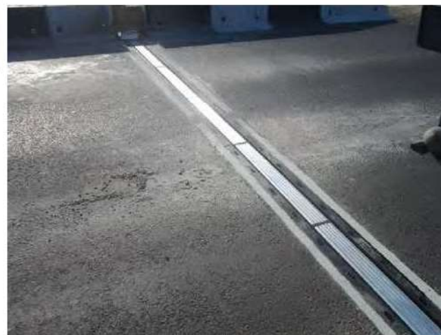
PROIECT : REABILITARE DN2 FOCSANI - ADJUD
